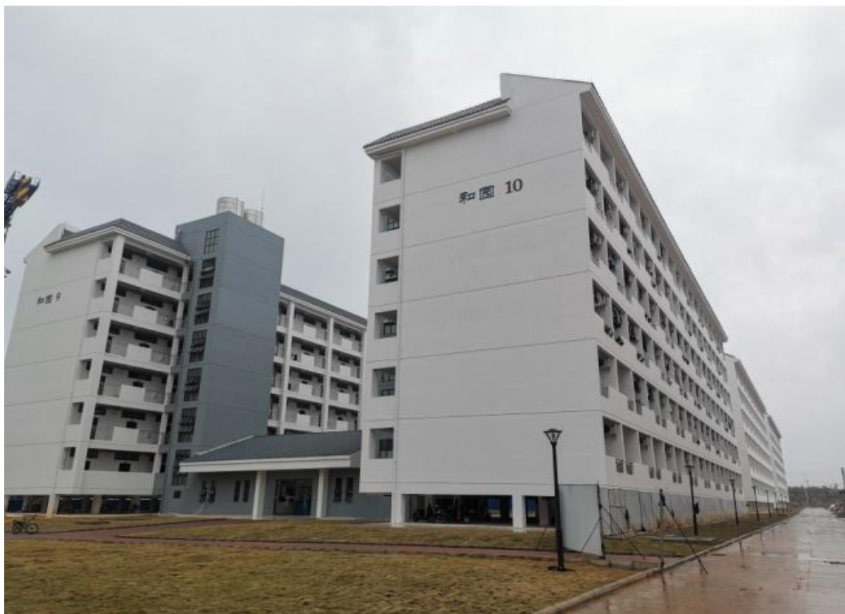
图 5-6 建成的南区学生公寓 5#-10#楼
